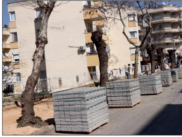
Halil Çulhaoğlu Caddesi Kaldırım Çalışması
