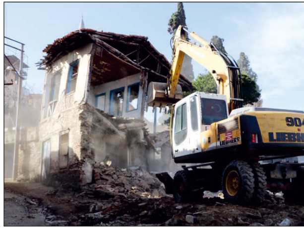
Kaziroğlu Sokak Metruk Bina Yıkımı
