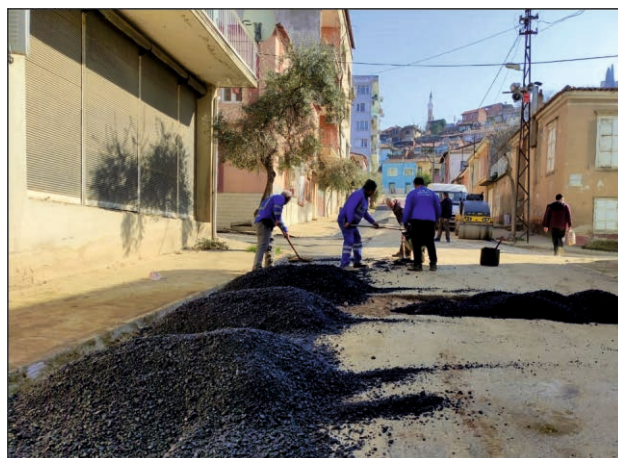
Aydınöğlü Caddesi Asfalt Yama Çalışması
