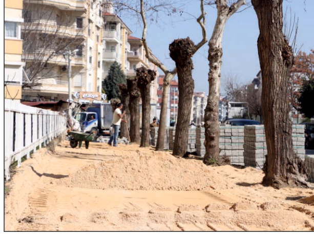
Halil Çulhaoğlu Caddesi Kaldırım Çalışması
