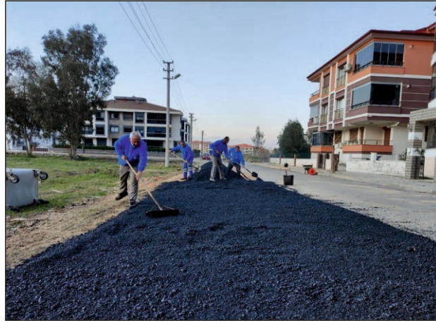
30 Ağustos Caddesi Asfalt Yama Çalışmaları
